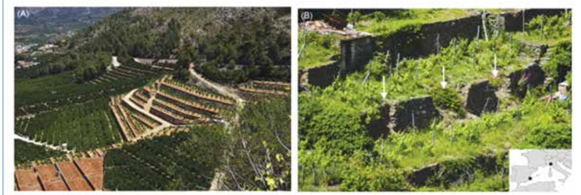
شکل ۳: تراس های کشاورزی در اسپانیا و ایتالیا. (A) سیستم تراس محفوظ برای کشت مرکبات در والنسیا (اسپانیا)؛ (B) شکست های تراس (فلش سفید) به علت راه سازی زمین در کورنیگلیا، سینک ترا (لیگوریا، ایتالیا)
